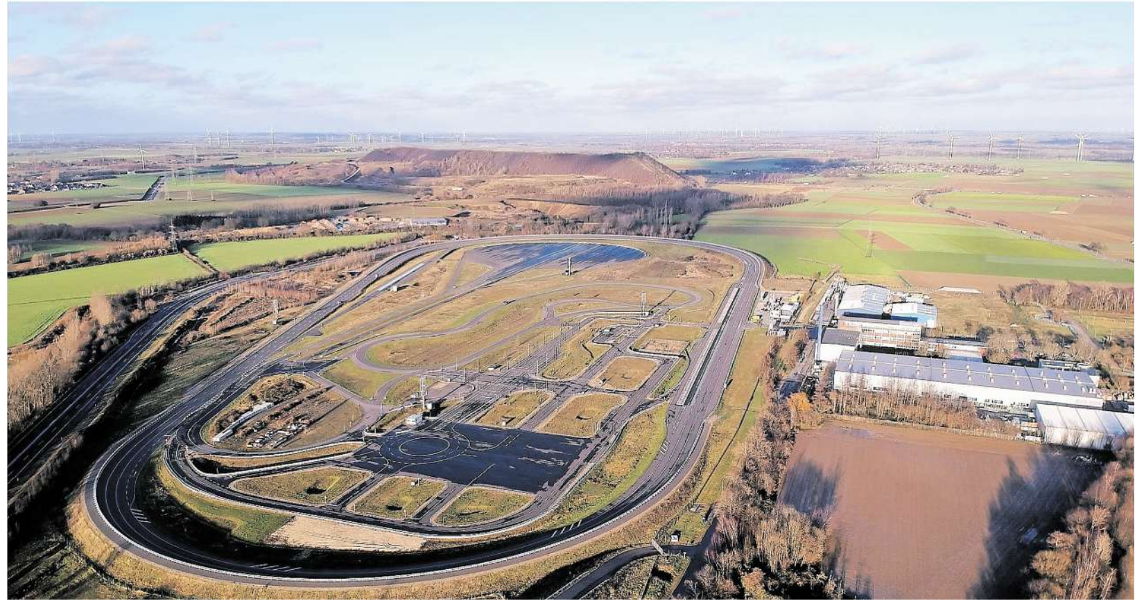
Für das Areal der ehemaligen Zeche Emil Mayrisch gibt es viele Pläne. Dort befindet sich heute das Aldenhoven Testing Center. Im Umfeld sollen Unternehmen aus dem Automotive-Bereich angesiedelt werden. FOTOS: GUIDO JANSEN
